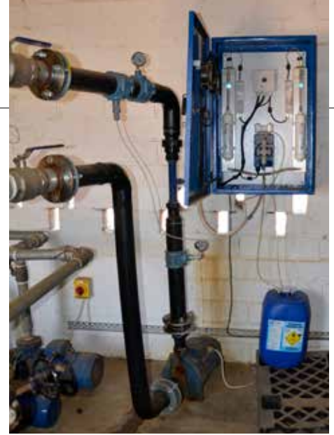
Die Puricare-stelsel bestaan uit osoonligte in buise, van waar die osoon dan saam met waterstofperoksied by die water gevoeg word om suurstofryke watermolekules te vorm.
